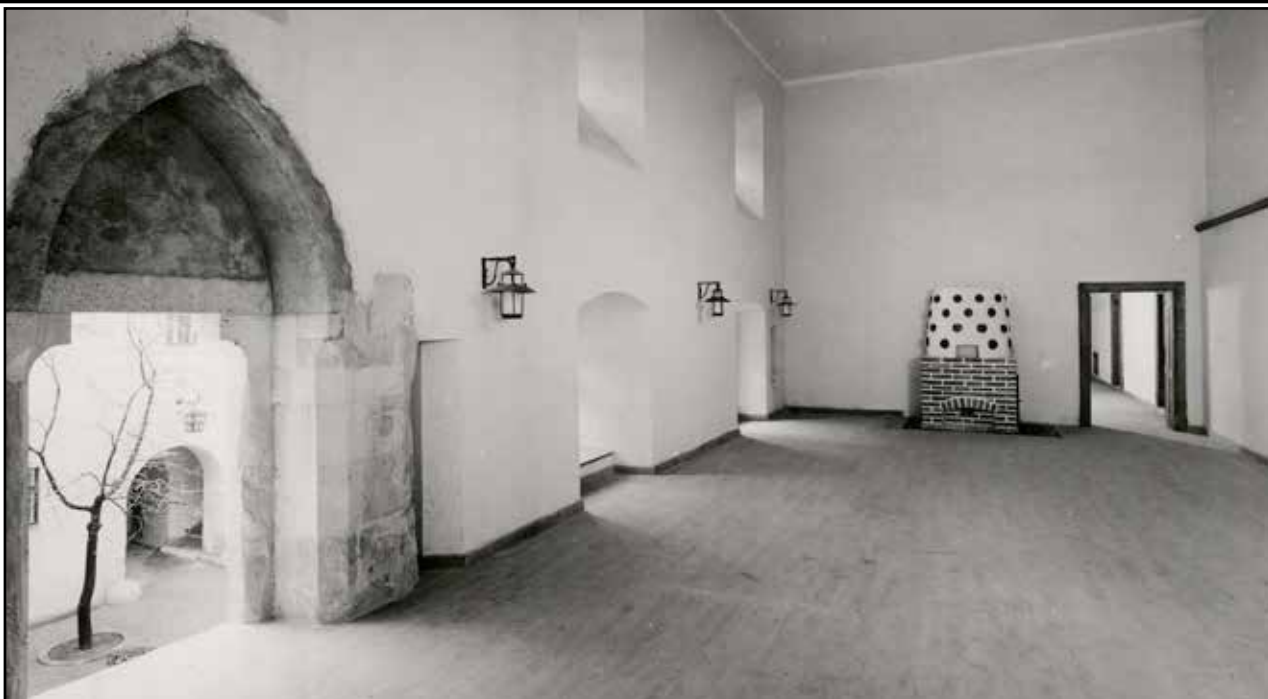
Det kungliga kapellet efter rekonstruktion för Wehrmachts ändamål mellan 1939 och 1941.
