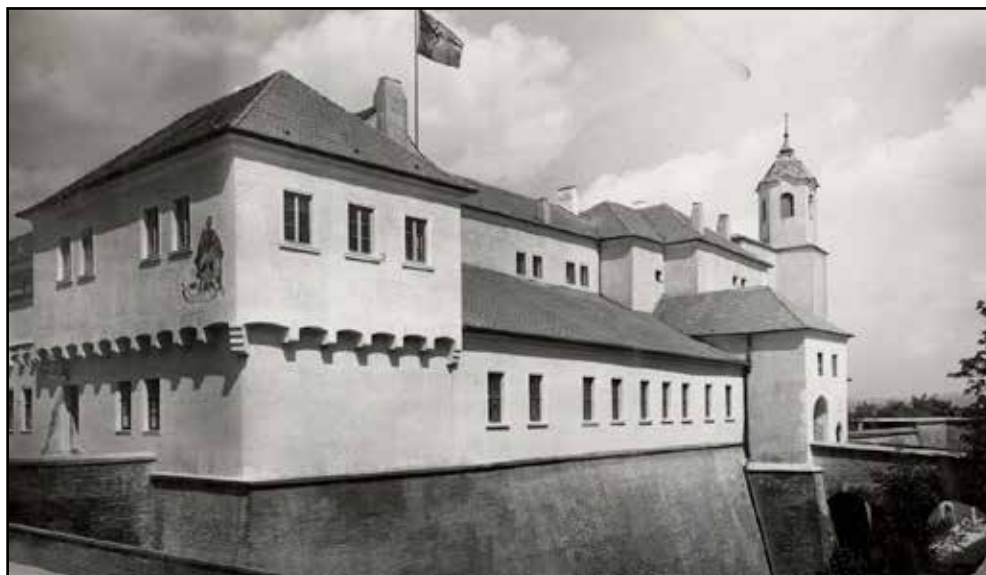
Špilberk, cazarmă a Wehrmacht-ului german. HERBERT ORTH (?). Špilberk. Vedere a aripii de est a castelului. În jurul anului 1941.
