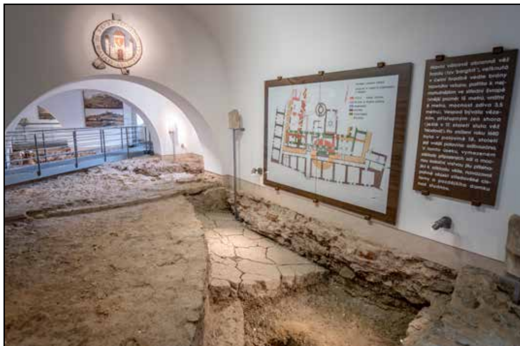
中世に造られた城（円筒形の塔）の基礎部分（基礎が一部見えている部分）
