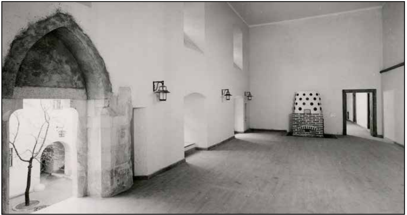
Khu vực nhà nguyện hoàng gia sau khi được xây dựng lại phục vụ mục đích của Lực lượng vũ trang quân đội Đức Quốc xã trong các năm 1939 - 1941
