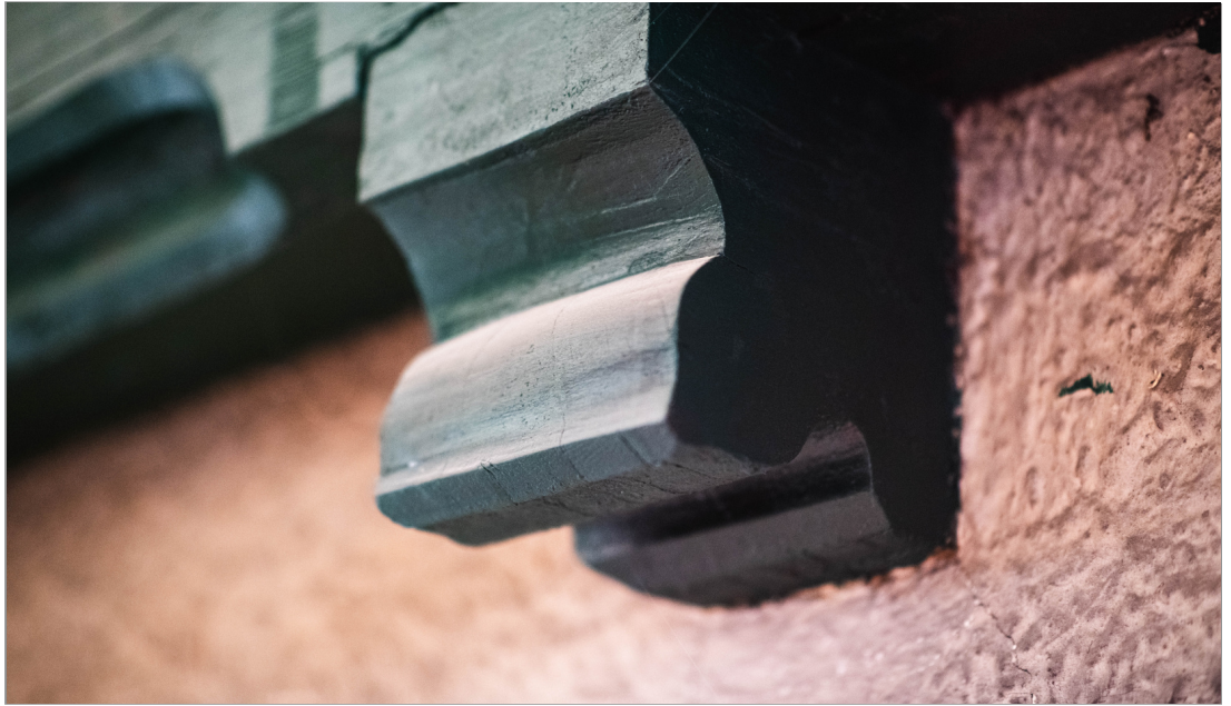
Detail eines hölzernen umlaufenden Gesimses mit profilierten Konsolen
