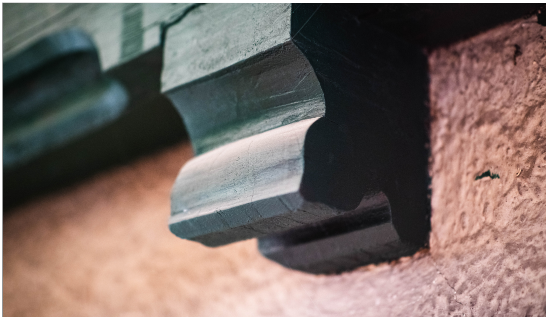
Detail kordonové dřevěné římsy s profilovanými konzolami
