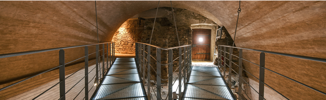
↓ SOUČASNÁ PODOBA INTERIÉROVÝCH PROSTOR BASTIONU
