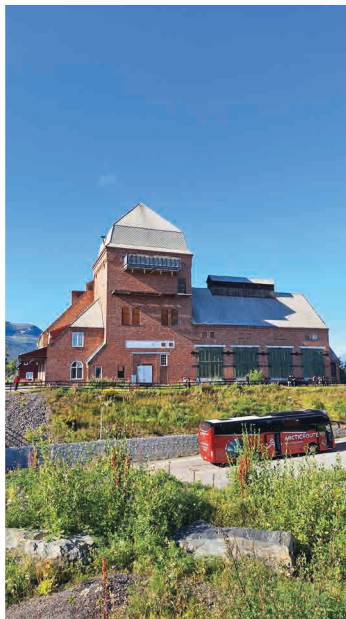
Obr. 6 Budova pro transformátory u polární železnice u Abisko, foto Hynek Zbranek
