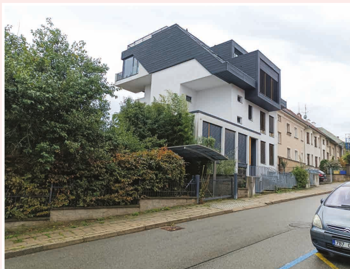
Obr. 6 Soukopova 3 – transformace přiměřeného tradičního domu v nekontextuální architektonickou exhibici upřednostňuje zájmy jednotlivce nad společnou kvalitou bydlení v místě. Foto autor.
