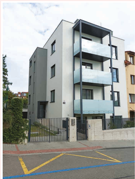
Obr. 4 Wolkerova 10 – přestavba rodinného domu na bytový dům se čtyřmi byty přináší do klidné ulice intenzivnější využití s větší dopravní zátěží. Foto autor.
