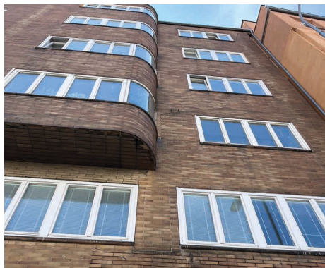
Obklady na fasádě domu na Křenové 14 směrem do ulice. Foto: Hrdina Pavlík. Tiles on the façade of the building at Křenová 14, facing the street. Photo: Hrdina Pavlík.
