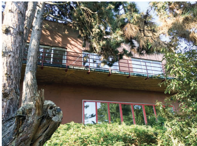
Přední fasáda bývalého domu Otto Eislera na Neumannově 10. Foto: autorka. Front façade of Otto Eisler's former home at Neumannová 10. Photo: author.
