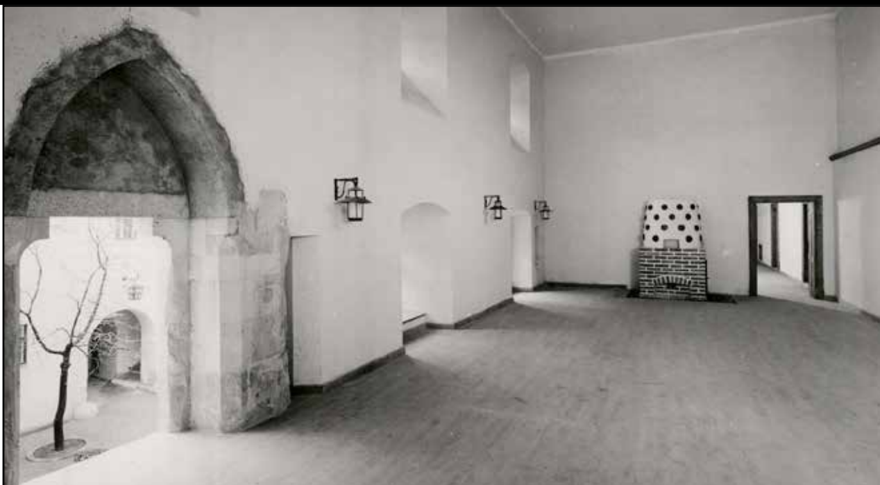
El espacio de la capilla real después de la reconstrucción para los fines de la wehrmacht de los años 1939 - 1941.
