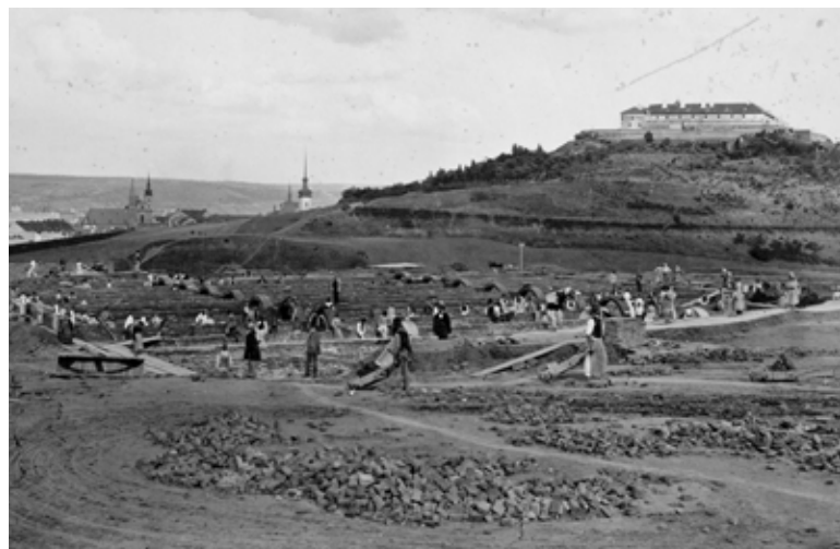
Bau des Wasserreservoirs auf dem Gelben Berg, Spielberg im Hintergrund (vor 1900)
