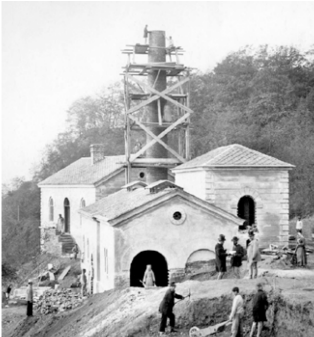
Bau der Pumpstation (1870 - 71)
