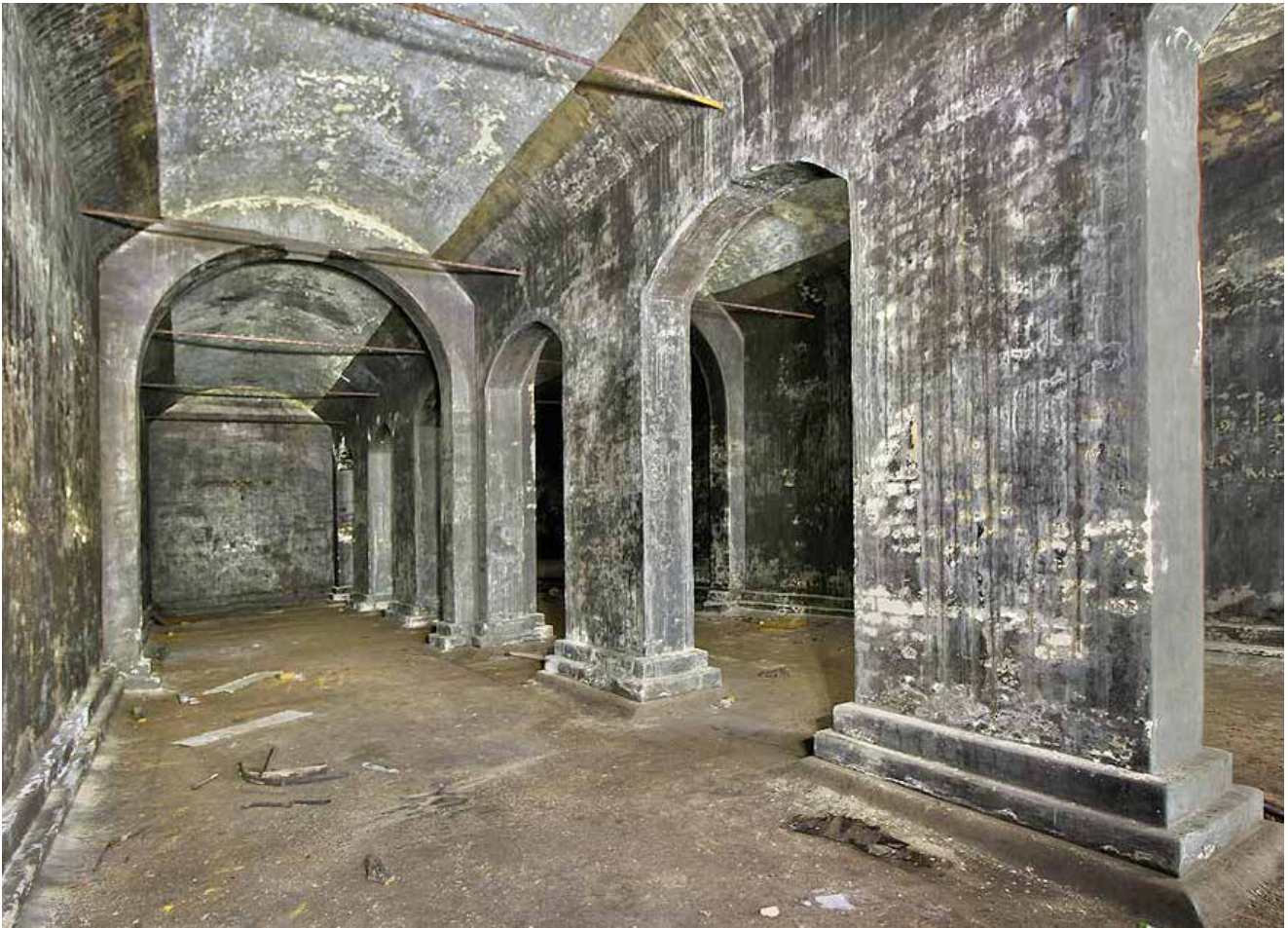
Älteres Wasserreservoir vor dem Umbau
