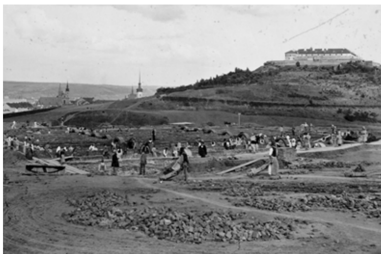
Stavba vodojemů na Žlutém kopci, v pozadí Špilberk (před r. 1900)
