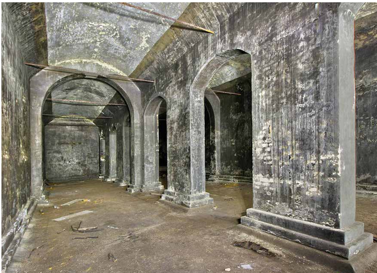
Starší vodojem před rekonstrukcí
