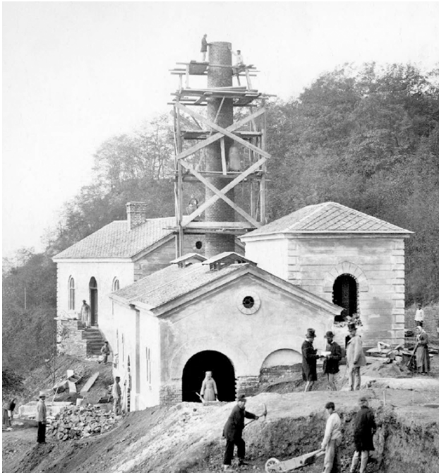
Bau der Pumpstation (1870 - 71)
