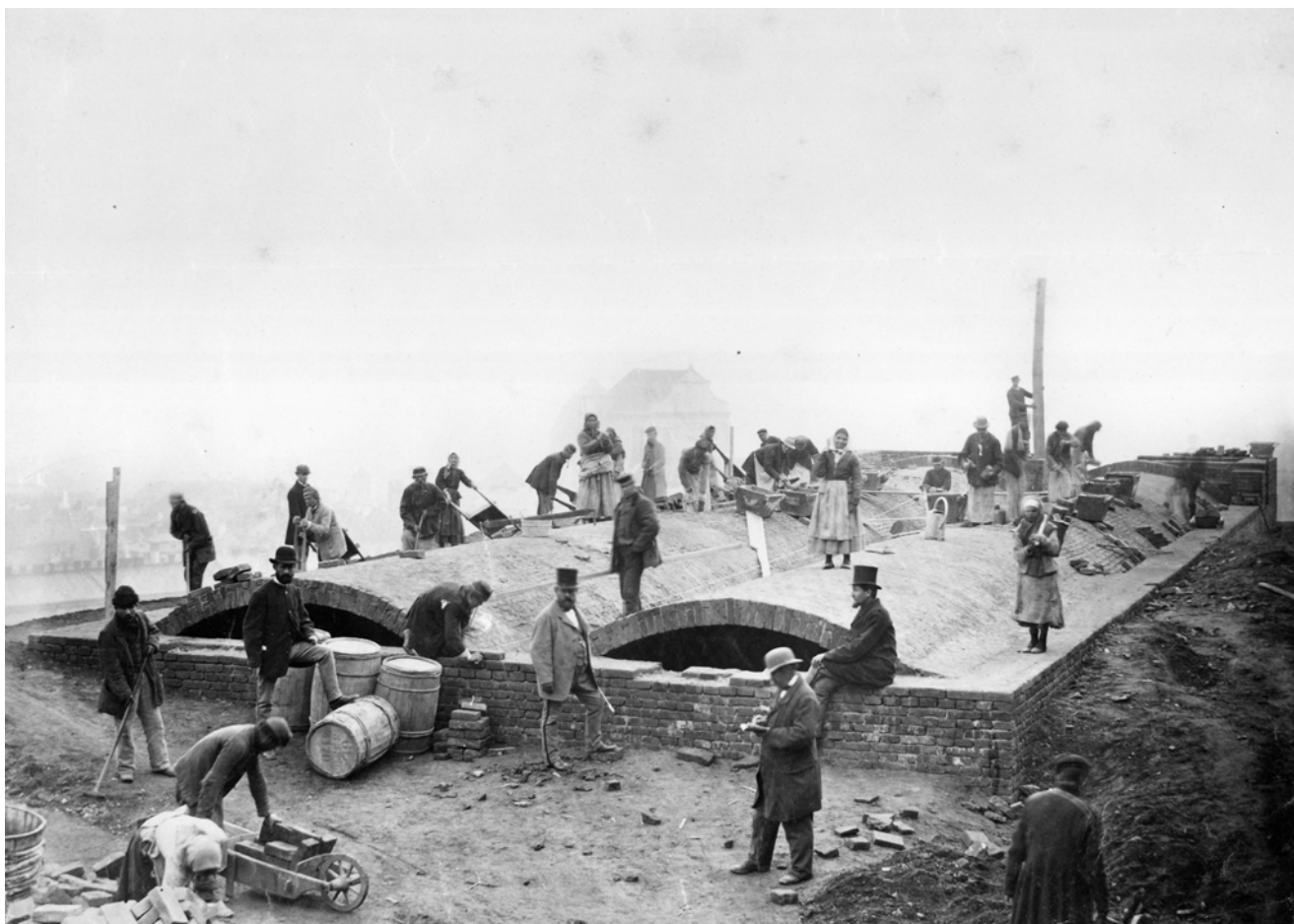
Stavba staršího vodojemu (1870 - 71)
